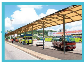
澳門外港客運碼頭 Macau Ferry Terminal
