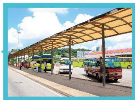
澳門外港客運碼頭 Macau Ferry Terminal
